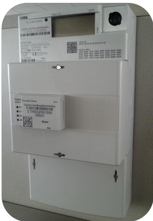
Abbildung 39 Zähler mit SMGW, Modulabdeckung und Klemmenblockabdeckung.
